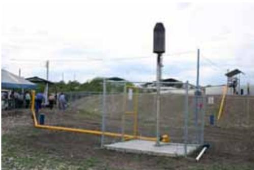
Foto 5. Equipo de medición del biogás y quemador. Imagen: Agcert
