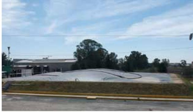
Foto 12. "Cámara de Prefermentación, Biodigestor Anaerobio tipo Laguna.
