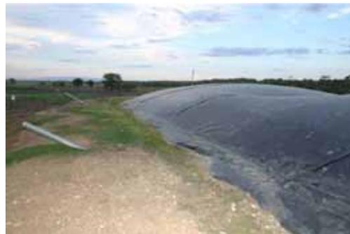
Foto 6. Biodigestor tipo "bolsa" con cobertura en plástico. Imagen: Agcert
