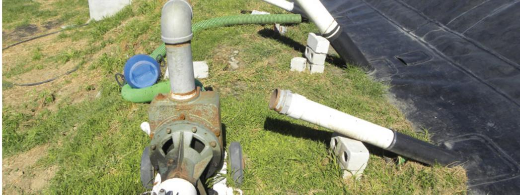
Recirculación de digestatos por bomba móvil
